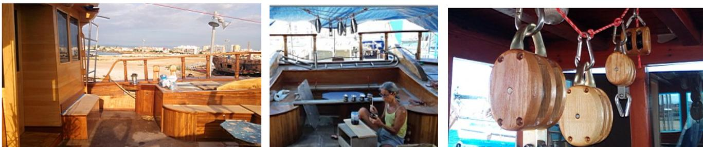
Maintenant on protège le roof pour installer un bastingage en inox autour du bateau. On se raccorde sur le balcon avant existant, hauteur 90cm.
