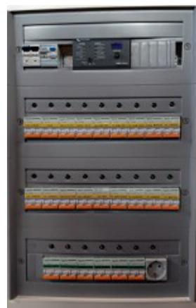
Les 4 solaires du roof ( $4 \times 345W = 1380W$  crête ou 57,5 Ah en 24V) sont connectés via des passe-cables à un coffret de coupure, puis au contrôleur régulateur de 60A. Après le contrôleur, le positif passe par une coupure pour arriver dans le coffret des barrettes de cuivre. Dans ce coffret, positif et négatif de chaque couple de batterie (260Ah /24V) sont reliés selon leur polarité respective pour se relier à l'armoire Quattro Victron.
