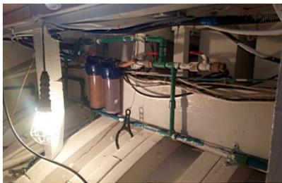
Un espace est réservé pour la plomberie, l'installation du tank d'eau grise de 270 litres, du dessalinisateur de 100 à 120 litres/heure, des pompes de pressions d'eau, des filtres.
