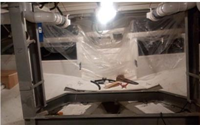
Le portique installé, on voit le détail d'un montant avec les gaines d'air.
