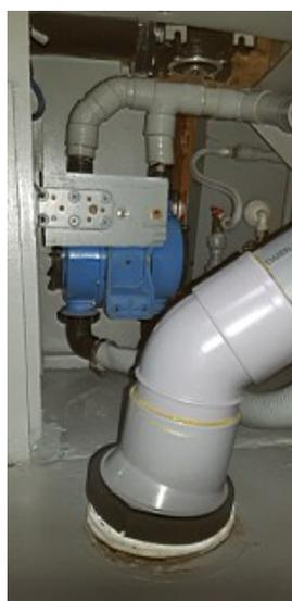
Le réducteur de pression et le compteur d'eau sont fixés sur le réseau d'eau du quai.
