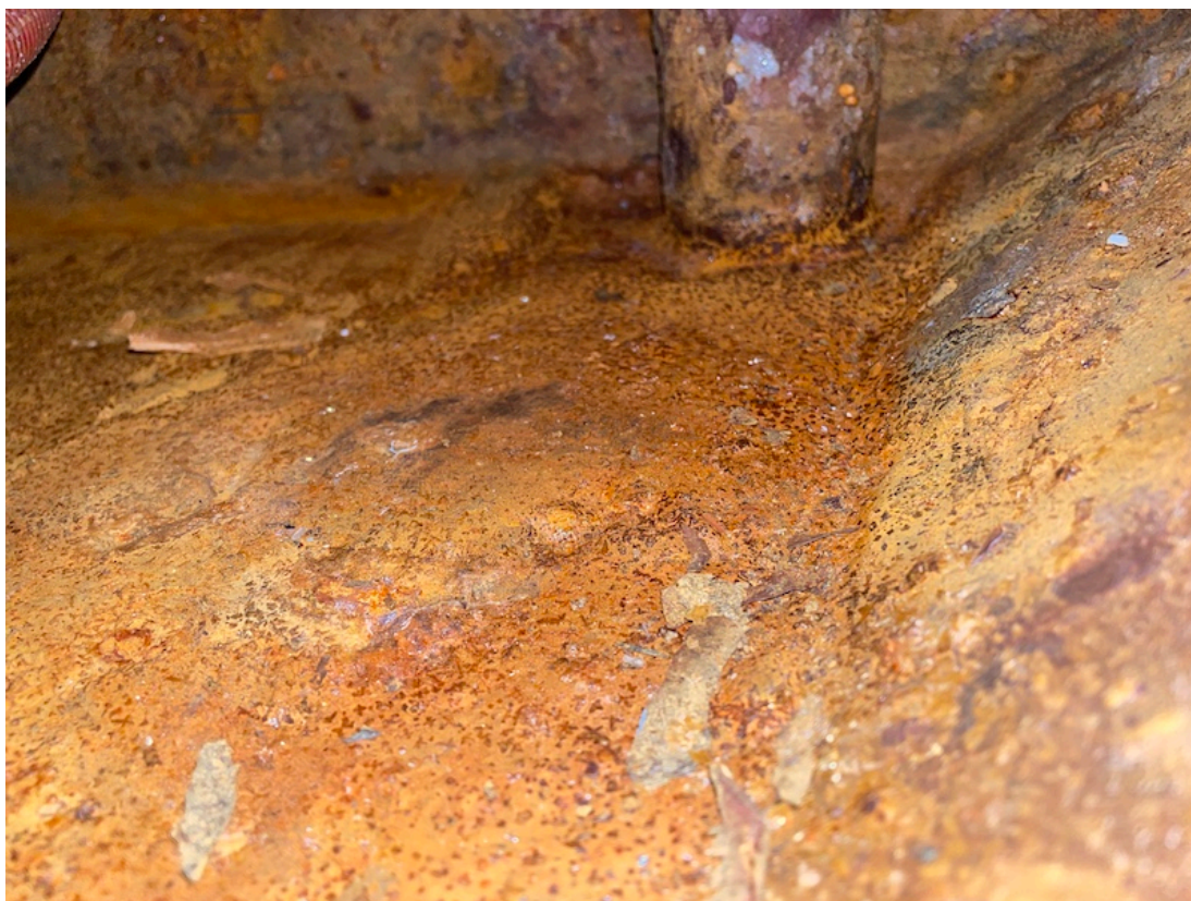
Abb.#10: aufgeblühter Stahl der Bodenplatte unterhalb der Duschwanne
