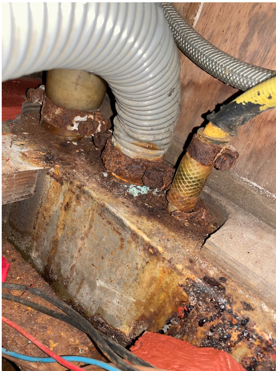
Abb.#11: Einfüllstutzen des hinteren Fäkalientanks, starke Korrosion am Tank, mit großer Wahrscheinlichkeit ist der Tank durchgerostet
