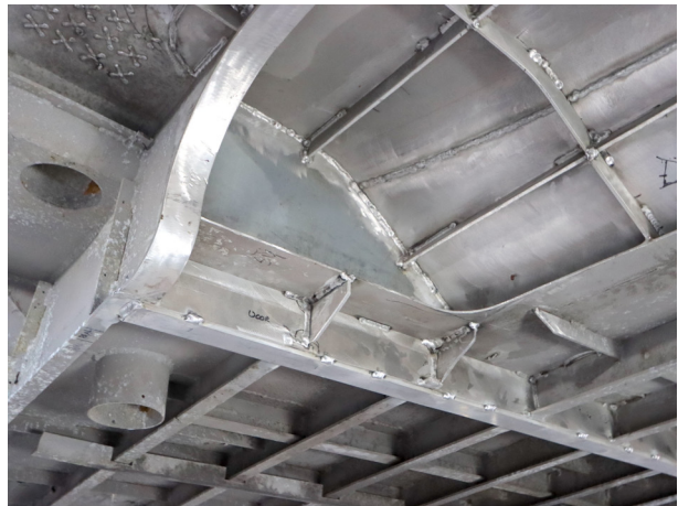
Auch das Deck und der Aufbau der Aluminium-Spantenkonstruktion wurden bereits an vielen Stellen überarbeitet und verstärkt.
