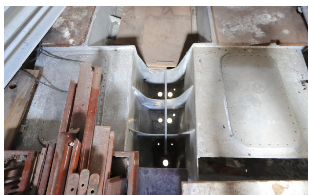
Auch im Kielbereich wurde die Struktur gründlich saniert, zusätzlich soll der Kielsumpf aufgedoppelt werden, bevor der Bleikiel wieder montiert wird.
